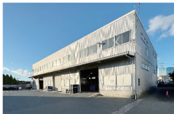
磐田物流センター内 代行センター
