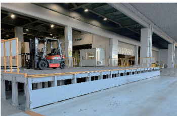
磐田物流センター2階 トラック積降・積込ステージ
